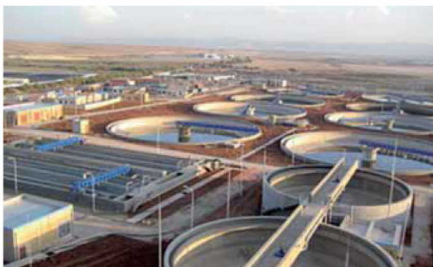
La station d'épuration d'El Kerma
