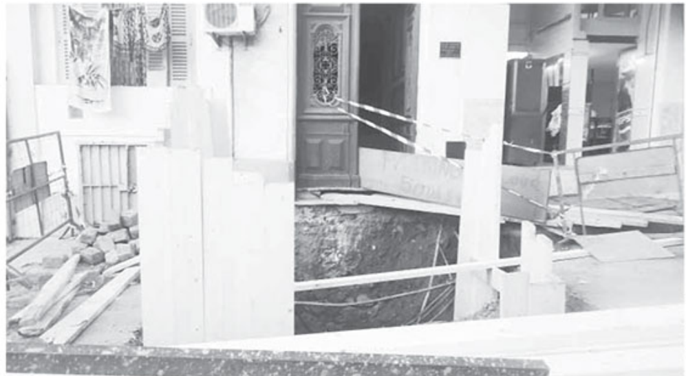
Les casses sur une conduite d'AEP provoquent des perturbations de l'alimentation en eau
