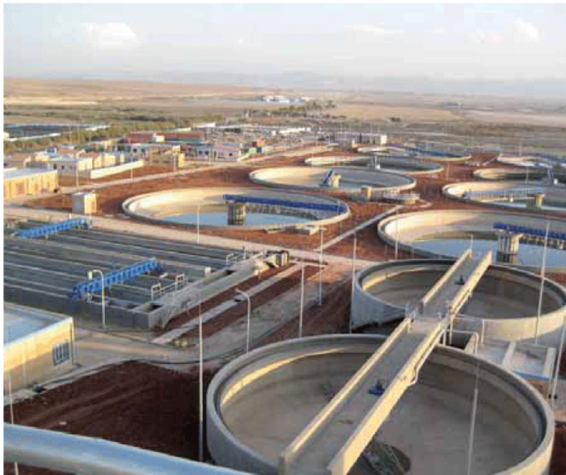
Une station de traitement et d'épuration des eaux usées
