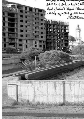
وحدة معالجة المياه المستعملة بومرداس
